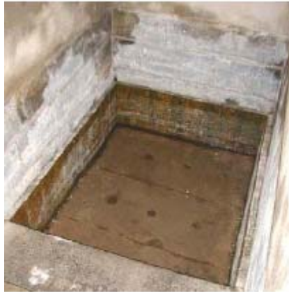
איור 12: רצפה מחוררת במקווה של בישהיים [Bischheim, ע"י שטרסבורג] משנת ה-ת"פ [1720] בערך
